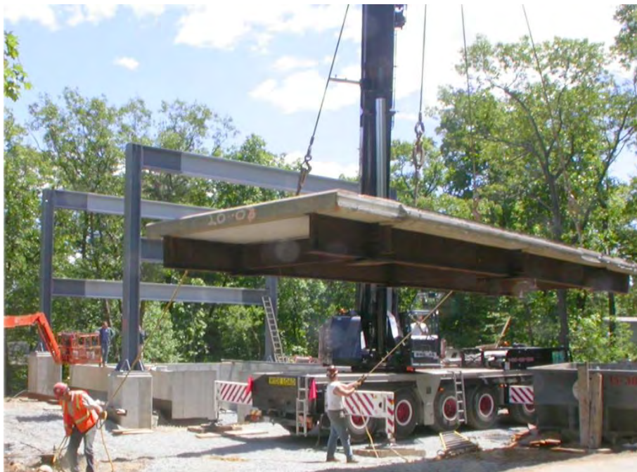
Figur A. 3 Big Dig House, USA
