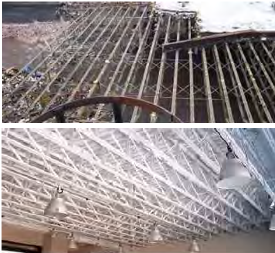
Figur A. 8 Återanvända fackverksbalkar, 740 rue Bel-Air, Montreal
