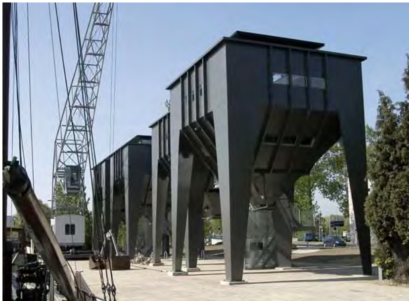
Figur 2.12 Från silo till kontor, Utrecht ( www.sustainablesteel.eu )
